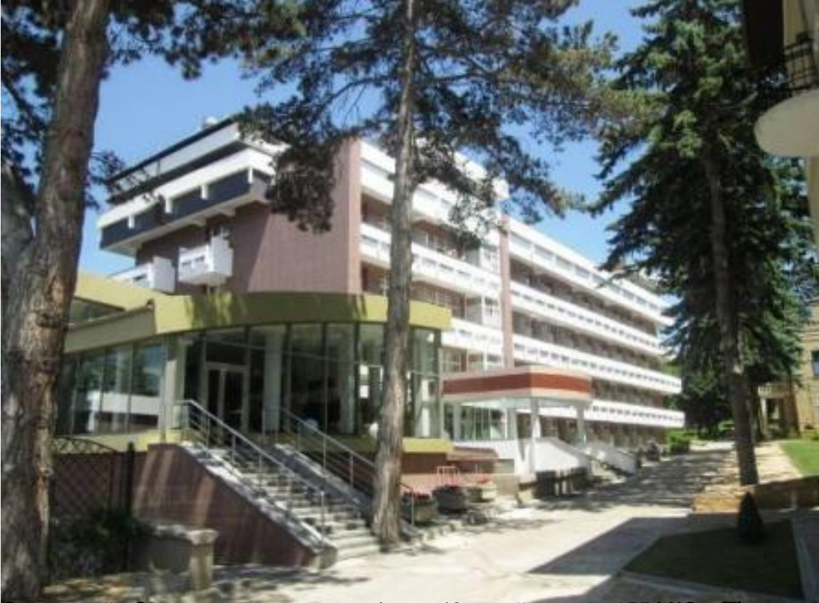
Вид здания с лестницей
